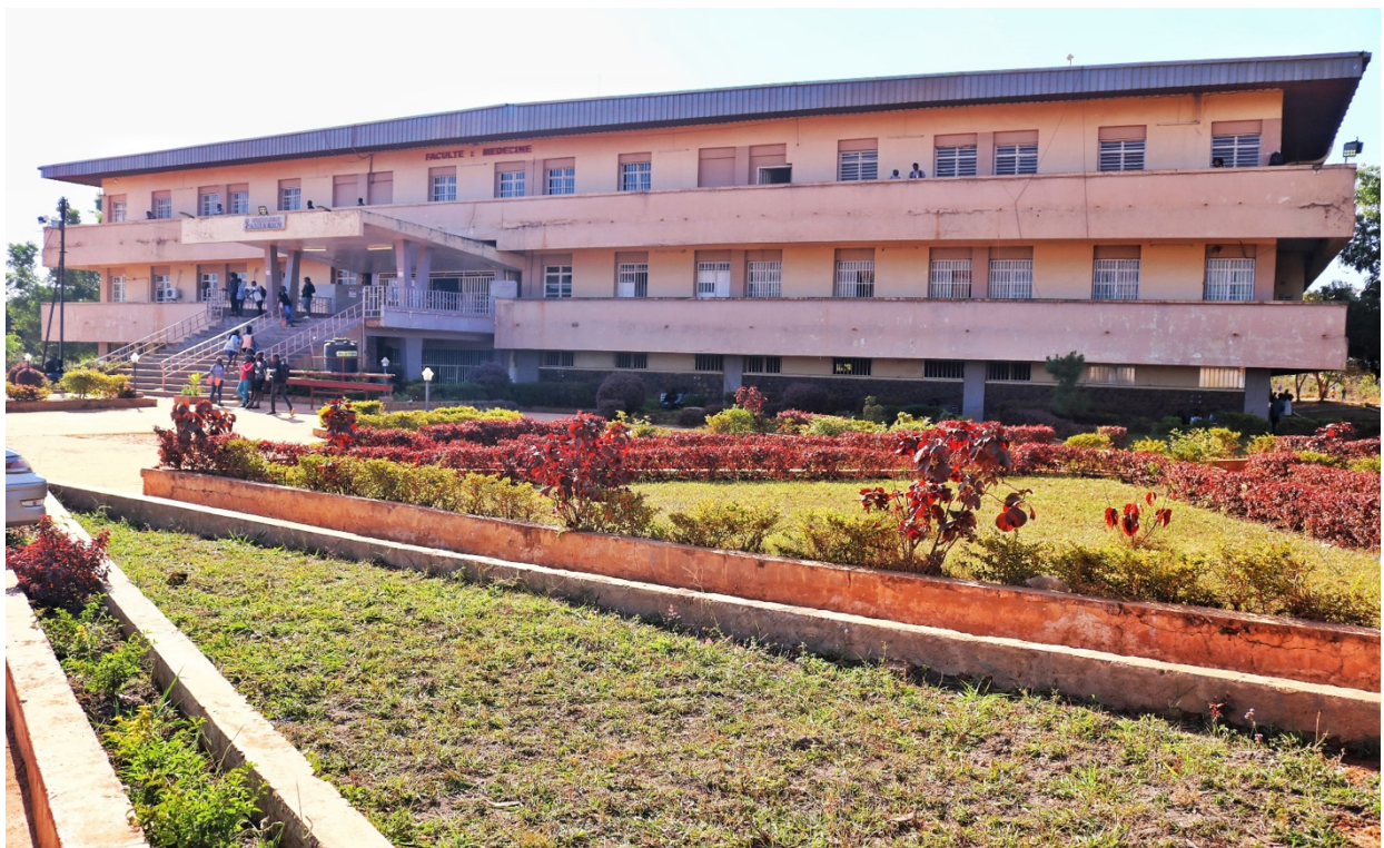
Figure 1. Façade principale de la Faculté de Médecine de l'Université de Lubumbashi
